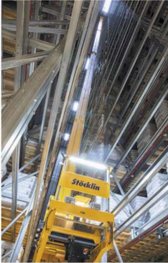
Eine Antipendel-Software gleicht gefährliche Pendelbewegungen bei der grossen Höhe aus und sorgt für Stabilität.
