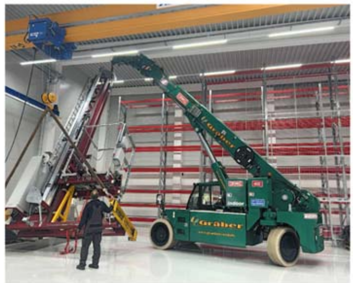
Präzisionsarbeit mit Leichtgewicht: Das moderne Einmast-RBG für das 8,9 Meter hohe, integrierte Lager der Heppler GmbH CNC-Technik wurde per Normaltransport geliefert und mit Mobil- und Hallenkran eingebracht. Foto: Westfalia Technologies GmbH & Co. KG
